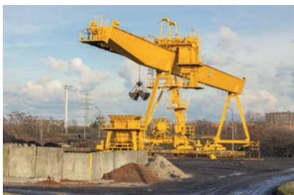
Voies de grue
