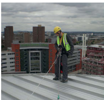
Entretien d'installations techniques
